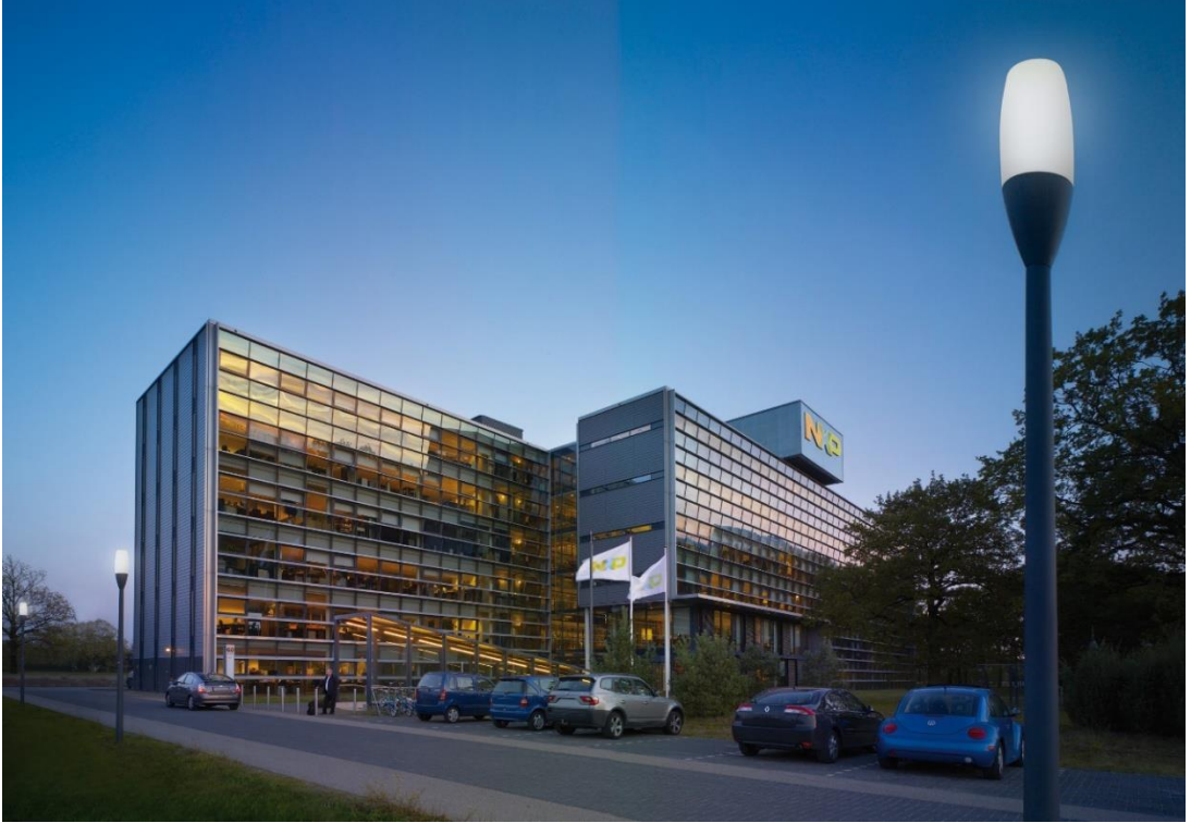
Şekil 3.4.3.1 Hollanda’da Bulunan NXP Merkez Binası
